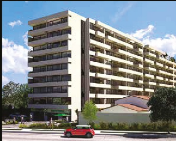
EDIFICIO VISTA LA FLORIDA La Florida
